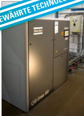
Das Herzstück der AQ-Baureihe ist ein einzigartiges Schraubenelement mit Wassereinspritzung für eine hocheffiziente, nahezu isothermische Kompression. Die Rotoren aus Polymerkeramik mit optimiertem Rotorprofil werden in wassergeschmierten Lagern geführt, damit das Kompressorelement nicht mit Öl kontaminiert wird, um ölfreie Luft erzeugen zu können.
